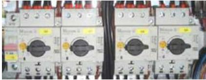
Abb. 4: Motorschutzschalter
