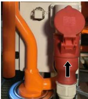
Abb. 29: Stromversorgung anschließen
